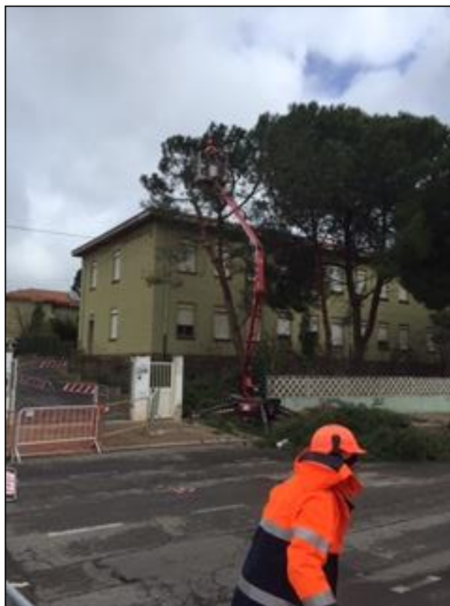
Figura 3: Lavori in corso_14.03.2019
