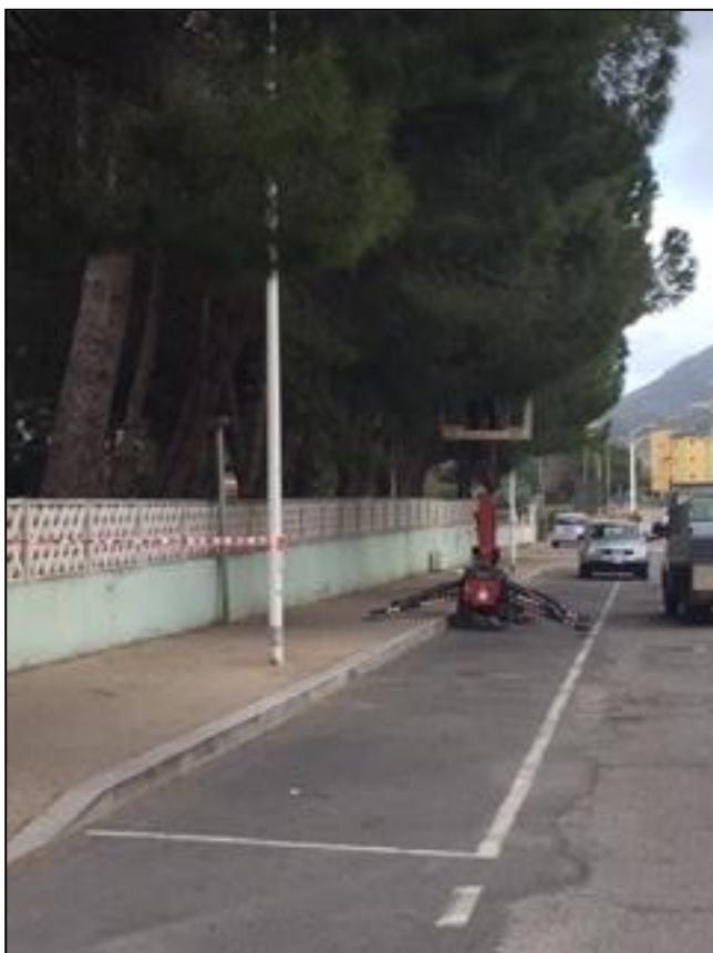
Figura 1: Lavorazioni in corso_14.03.19
