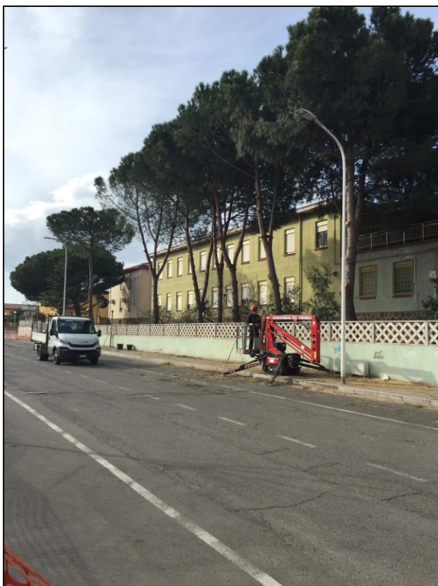
Figura 4: Lavori in corso di ultimazione_20.03.2019
