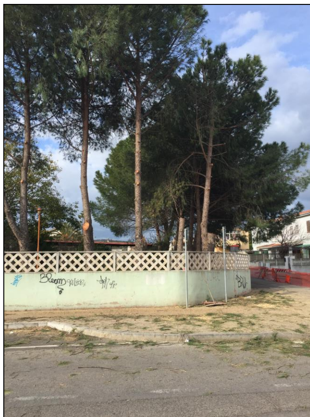
Figura 5: Lavori in corso di ultimazione_20.03.2019
