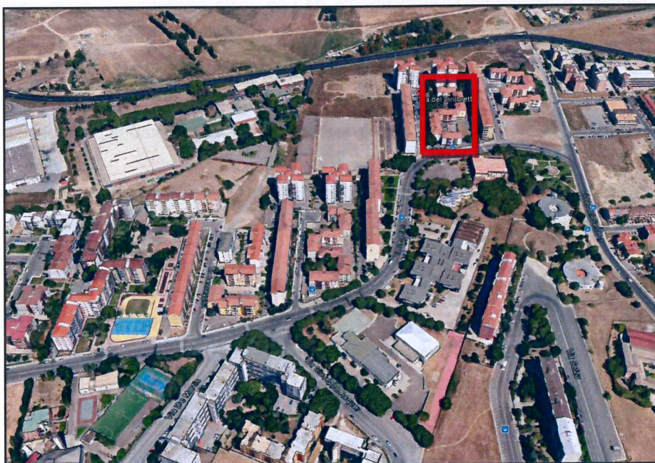
Inquadramento territoriale dei fabbricati
